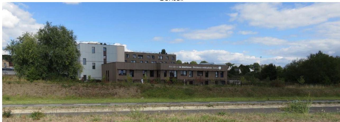
Vue sur la résidence médicalisée présente sur le site – Source : Even Conseil
