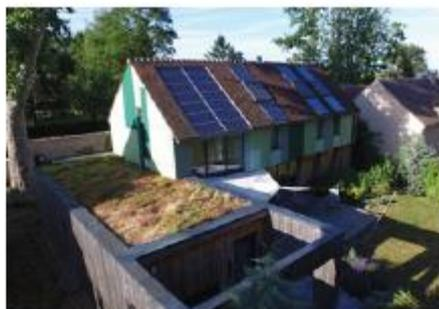
Il est possible d'installer plusieurs types de capteurs en toiture s'ils sont intégrés dès le début du projet comme un élément architectural en harmonie avec le dessin de la façade.
