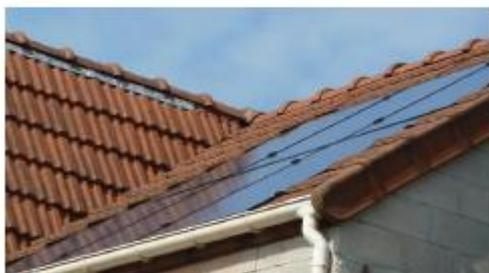
Si la technique le permet. Sinon, il est préférable de les positionner sur un autre support. Les capteurs encastrés sont affleurant du nu extérieur de la couverture (pas en saillies) sans surépaisseur ce qui limite l'impact visuel.
